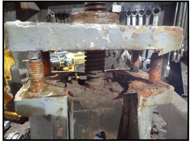
Mye rust og ingen bevegelse
