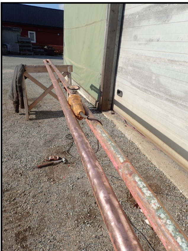
Vi bruke vinkelsliper for å fjerne korrosjon
