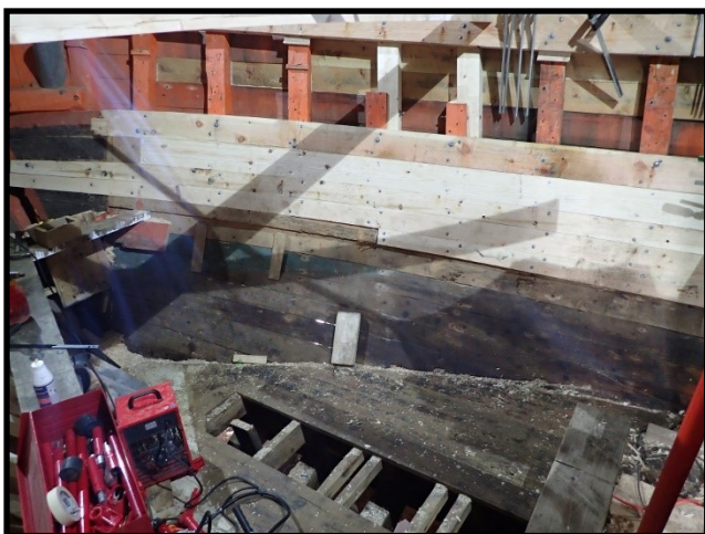
Livholt og garnering ferdig montert
