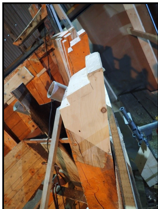
Reparasjon av spante topp
