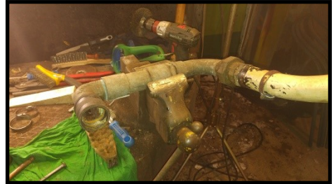
Rørdeler er dårlig
