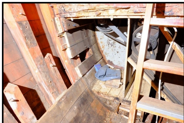
Vi demonterte tank for å for tilgang til garnering.
