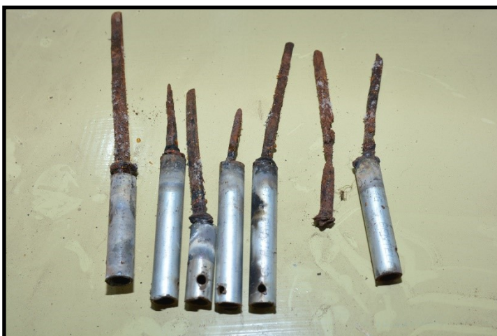
Tilstand av de gamle spiker
