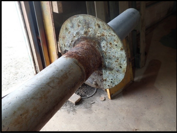
Eksosrør fra motor og ovn
