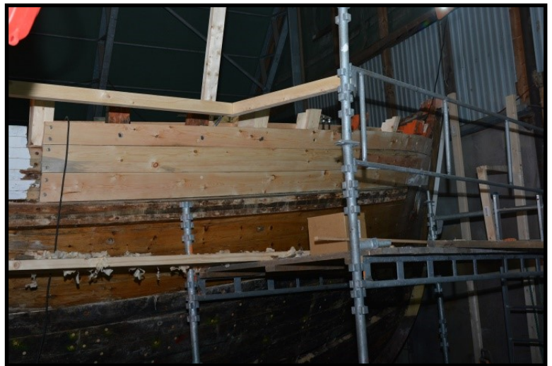
3 nye planker på stb side
