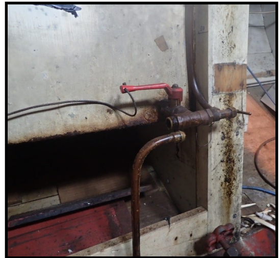
En av de rørledningene
