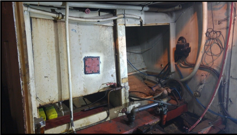
Tank på bb side.
