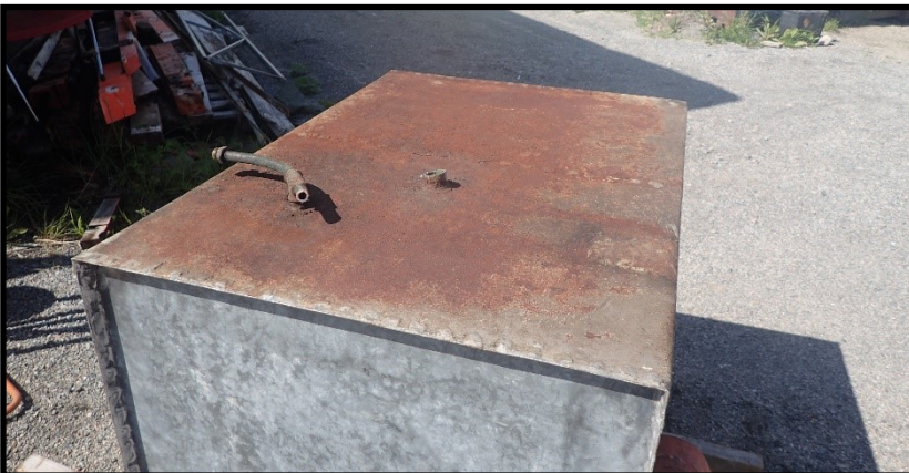
Overside av tank på bb side
