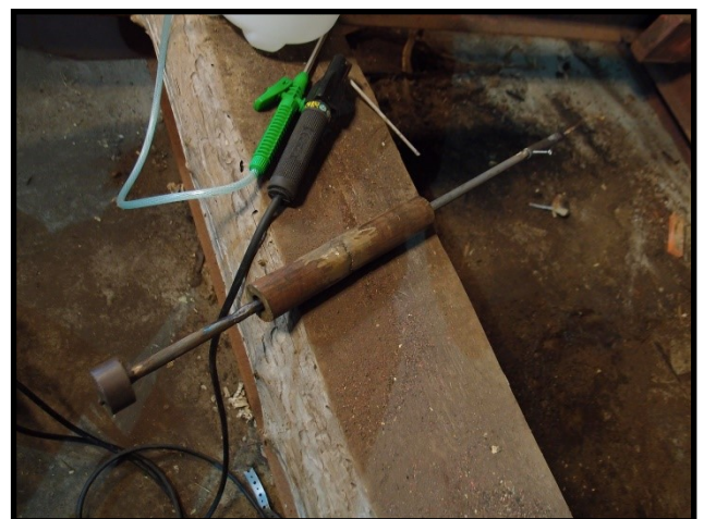
Vi bruke sveiseoperat for å trekke spiker.
