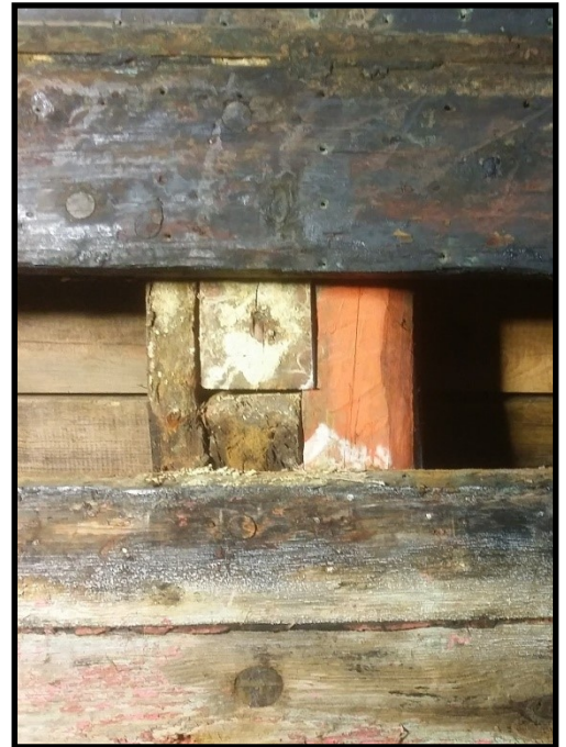
Spant fra 1936 (venstre) og spant fra 60 tallet
