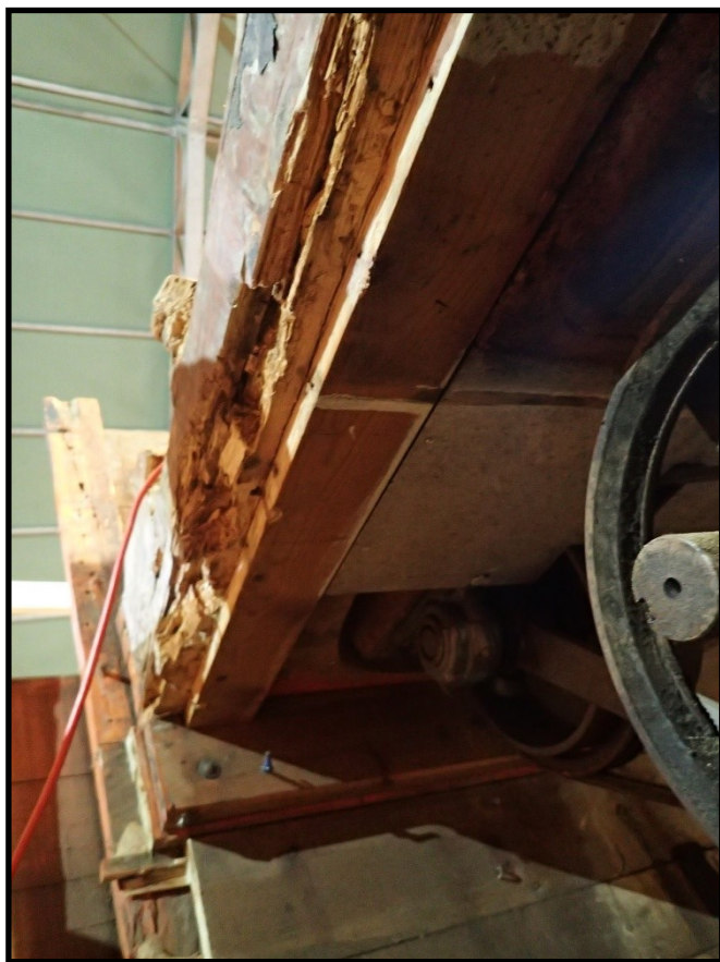
Bjelke under bakkplank er delvis dårlig på styrbord side.
