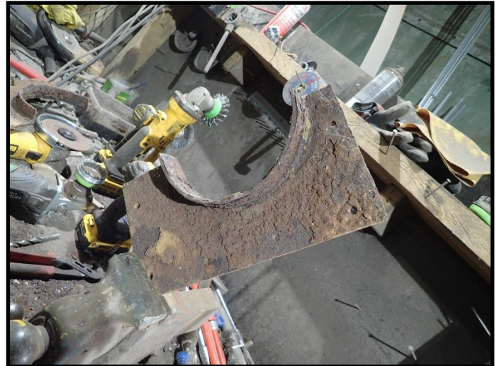
Dekkplate var dårlig men vi kan gjenbruke den
